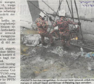
ANGGOTA bomba menyelamatkan timbunan besi cerucuk untuk mengeliminasi...
