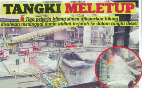
ANGGOTA bomba memadam kebakaran tangki menyimpan diesel kilang simen.
