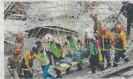
ANGGOTA bomba dan penyelamat serta polis mengumpul mayat seorang mangsa dalam kejadian runtuhannya bertingkat Terminal Bersepadu Gombak, Taman Melati, Kuala Lumpur, semalam. - UTUSAN/AMIR KHALID
