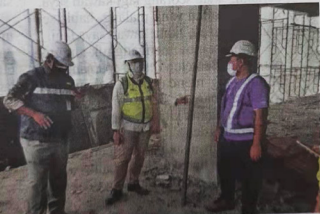
Pengarah Jabatan Keselamatan dan Kesihatan Pekerjaan WP Kuala Lumpur dan Putrajaya, Ir. Zamzurin Maarof (di kiri) meninjau lokasi...
